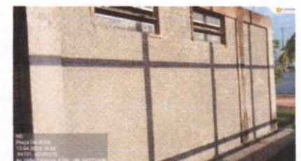
APLICAÇÃO DE CHAPISCO EM WC-S
