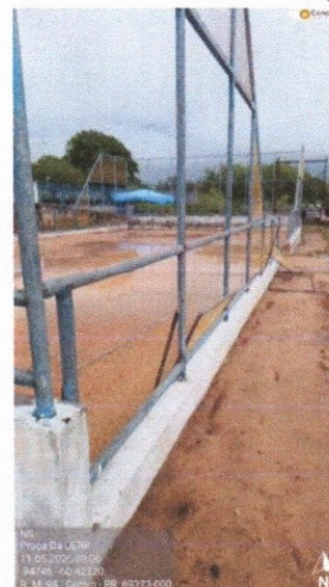
EXECUÇÃO DE MURETA E PINTURA DE MURETA E RETIRADA DE TELA DE ALAMBRADO
