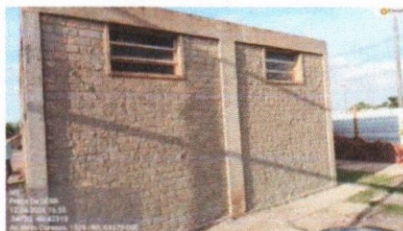
APLICAÇÃO DE CHAPISCO EM WC-S
