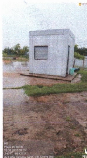
EXECUÇÃO DE REVESTIMENTO COM APLICAÇÃO DE SELADOR EM QUIOSQUE
