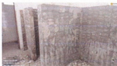
EXECUÇÃO DE DEOLIÇÃO DE REVESTIMENTO EM WC-S
