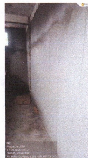
EXECUÇÃO DE REVESTIMENTO REBOCO EM QUIOSQUE
