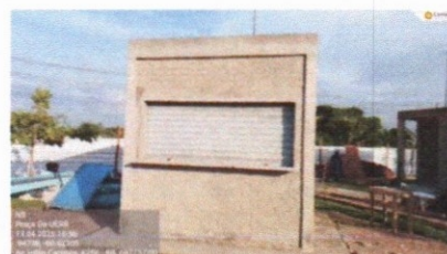
APLICAÇÃO DE CHAPISCO EM QUIOSQUE
