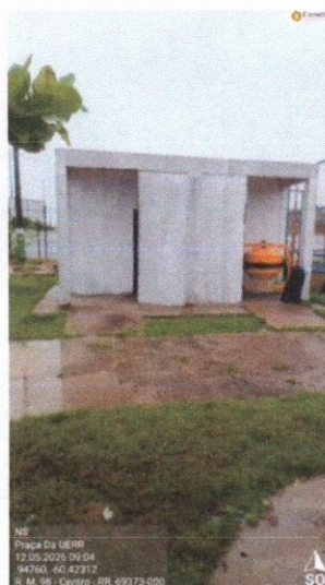
EXECUÇÃO DE REVESTIMENTO COM APLICAÇÃO DE SELADOR EM WC'S
