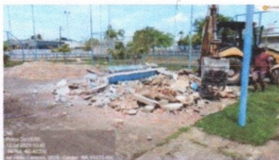
DEMOLIÇÃO DE QUIOSQUE
