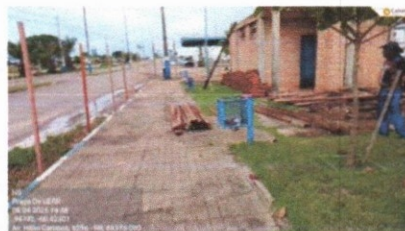
RETIRADA DE COBERTURA DE WC-S
