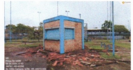
RETIRADA DE COBERTURA EM QUIOSQUE
