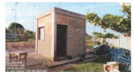
APLICAÇÃO DE CHAPISCO EM QUIOSQUE
