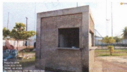
APLICAÇÃO DE CHAPISCO EM QUIOSQUE
