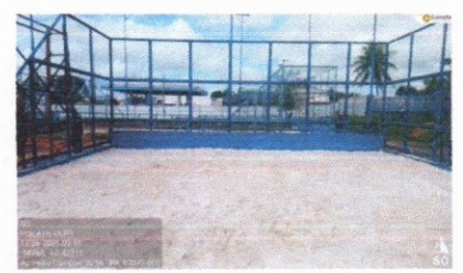
CAMADA DE AREIA EM QUADRA
