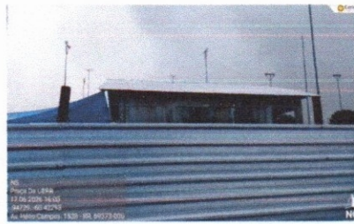
TAPUME E RECOBRIMENTO DE TELHAS METÁLICAS
