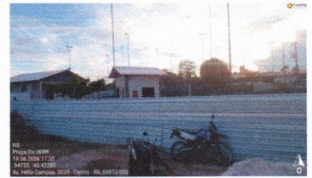
TAPUME E RECOBRIMENTO DE TELHAS METÁLICAS
