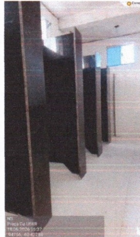
, DIVISÓRIA EM GRANITO E JANELA EM VIDRO TEMPERADO
