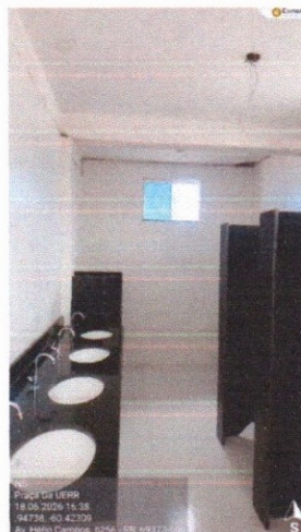
BANCADA DE LAVATÓRIO EM GRANITO, DIVISÓRIA EM GRANITO E JANELA EM VIDRO TEMPERADO
