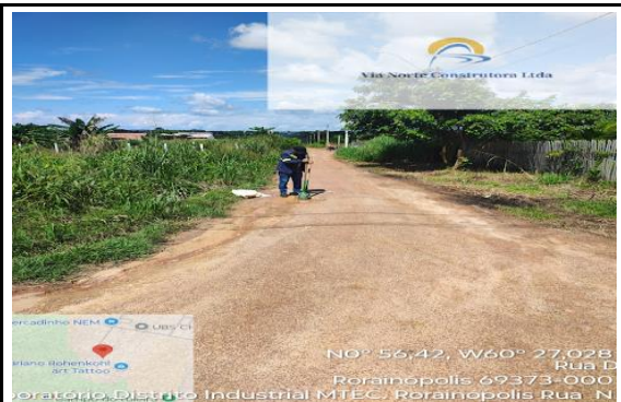
SONDAGEM RUA N
