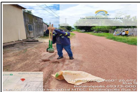
SONDAGEM RUA V
