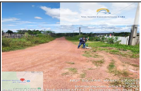
SONDAGEM RUA P
